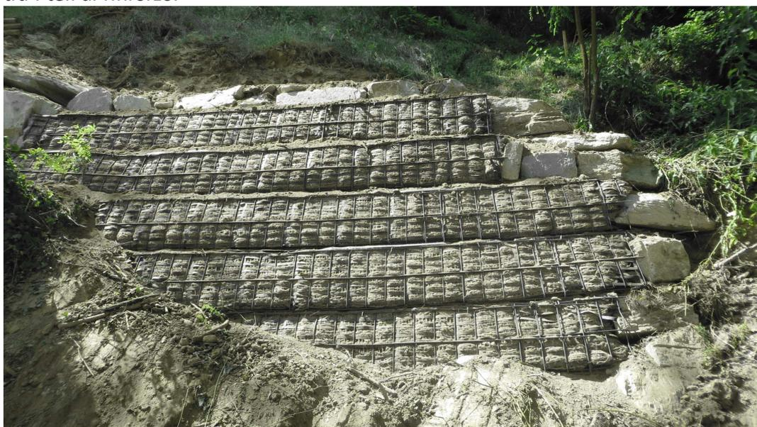
Terminata l'opera sarà necessario eseguire un'idrosemina a spessore in almeno due passaggi, contenente oltre alle sementi e al collante, quantità idonee di materia organica e mulch.
