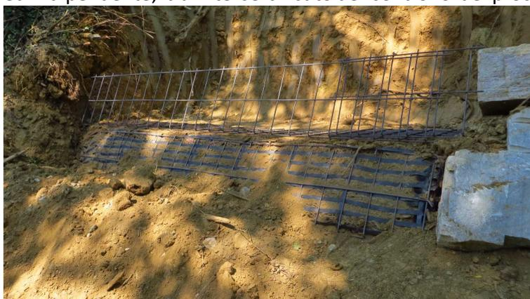
A tergo del paramento esterno inclinato sarà posto del terreno vegetale per uno spessore di almeno 30 cm e poi si provvederà alla stesa e compattazione del terreno per la formazione del rilevato strutturale; questa avverrà per strati di altezza pari a ca. 25-30 cm e per un totale pari alla distanza tra i teli di rinforzo.
