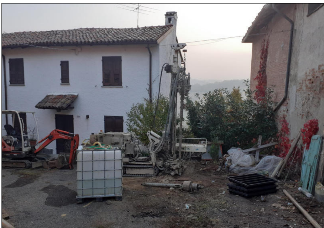
Sondaggio Geognostico S1 - Postazione.
